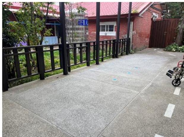
※說明：圍籬的木材老舊且不穩，為確保使用安全進行圍籬加固以及漆上保護漆；迴廊水泥磚地板因下陷造成不平及地面落差大，長輩行走時恐有跌倒疑慮，進行移除水泥磚工程並改為抵石子地板。
